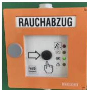
Damit die RWA die Funktion aufnimmt muss die Schreibe (Achtung Verletzungsgefahr) eingeschlagen werden und der schwarze Knopf tief gedrückt werden.
