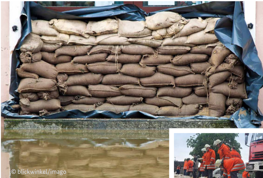
Schutzwälle aus Sandsäcken
