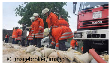
Schutzwälle aus Sandsäcken
